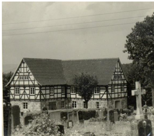
Friedhofskapelle mit Leichenhalle nach dem Umbau 1952
