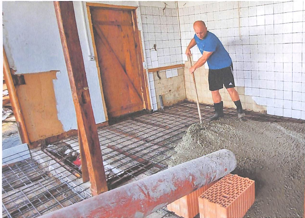
Umbau des Alten Kiosk in eine Pumpenstation / Beregnungsanlage
