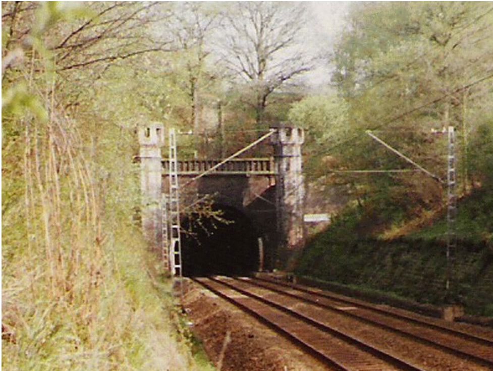
Nordportal , vom Bahnhof Guxhagen (Mai 2005) (Foto: Klaus Erbeck)
