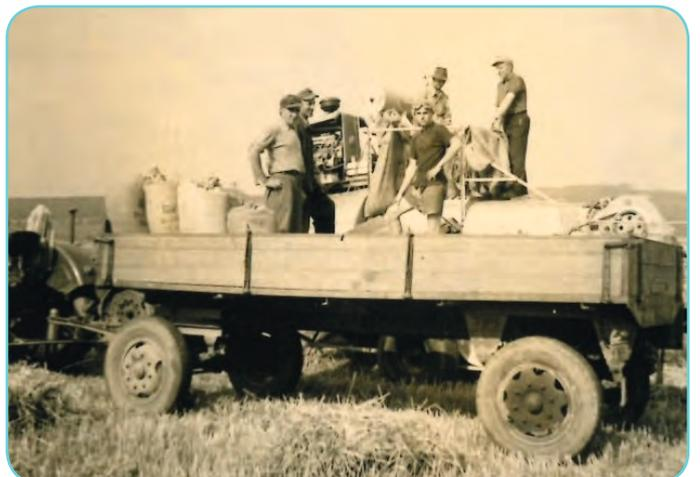
Einen weiteren Fortschritt brachte schließlich der selbstfahrende Mähdrescher, im Bild: Claas Matador mit Ulrich Meinke als Fahrer, der ab 1965 im Einsatz war. Die Körner wurden nun im mähdreschereigenen Tank gesammelt und am Feldrand mit automatischer Schnecke auf Wagen verladen. Der Einsatz der heutigen Mähdrescher mit Kabinen und Klimaanlage brachte dann endlich für die Fahrer einen staubfreien Arbeitsplatz.
