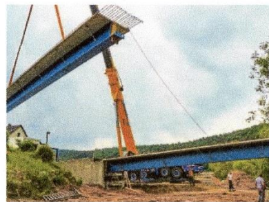
Mit zwei Kränen wird an der Baustelle gearbeitet: Vier von sechs Teilen sind montiert. Die anderen sind vor der Autobahnunterführung bei Ellenberg geparkt.
