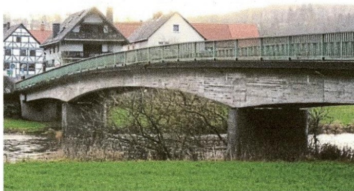
Wird ab 30. September abgerissen: Die Brücke in Büchenwerra.
