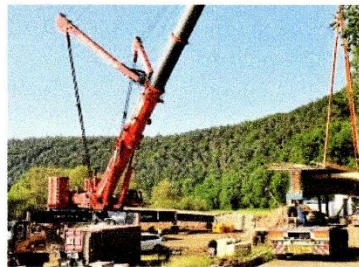
Alles vorbereitet: Das Mittelteil kommt an der Brückenbaustelle an.
