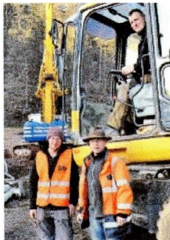
Sie bauen die neue Brücke: von links Angelo Schepp, Mike Grimm und Stephan Hanstein.
