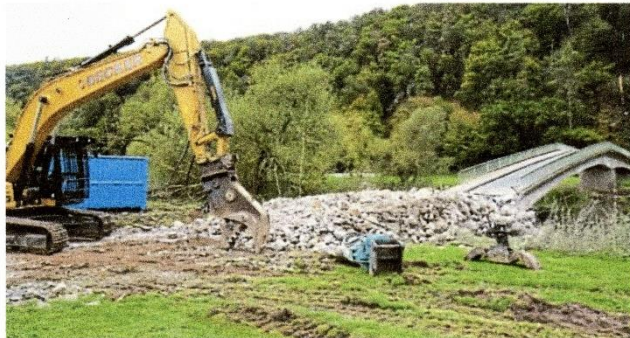
Abbrucharbeiten mit dem Pulverisierer: In Büchenwerra wird derzeit die Fulda-Brücke abgebrochen. Noch etwa sechs Wochen werden diese Arbeiten dauern. Danach wird an selber Stelle die neue Brücke errichtet.
