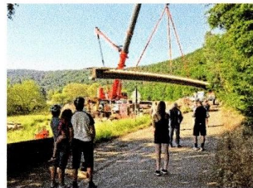
Zaungäste: Einige Zuschauer verfolgten die anspruchsvolle Arbeit an der Baustelle gespannt.
