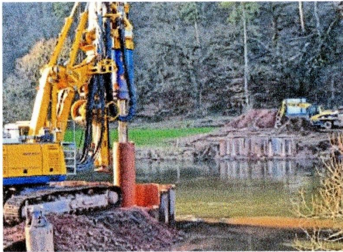
Hier soll bis Jahresende die neue Brücke stehen: Derzeit werden bei Büchenwerra Bohrpfähle gesetzt. FOTO: ROLF FÄRBER
